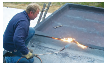
Verschweißte Dachbahnen
