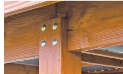
Stabile Pfosten- / Pfettenverbindung
